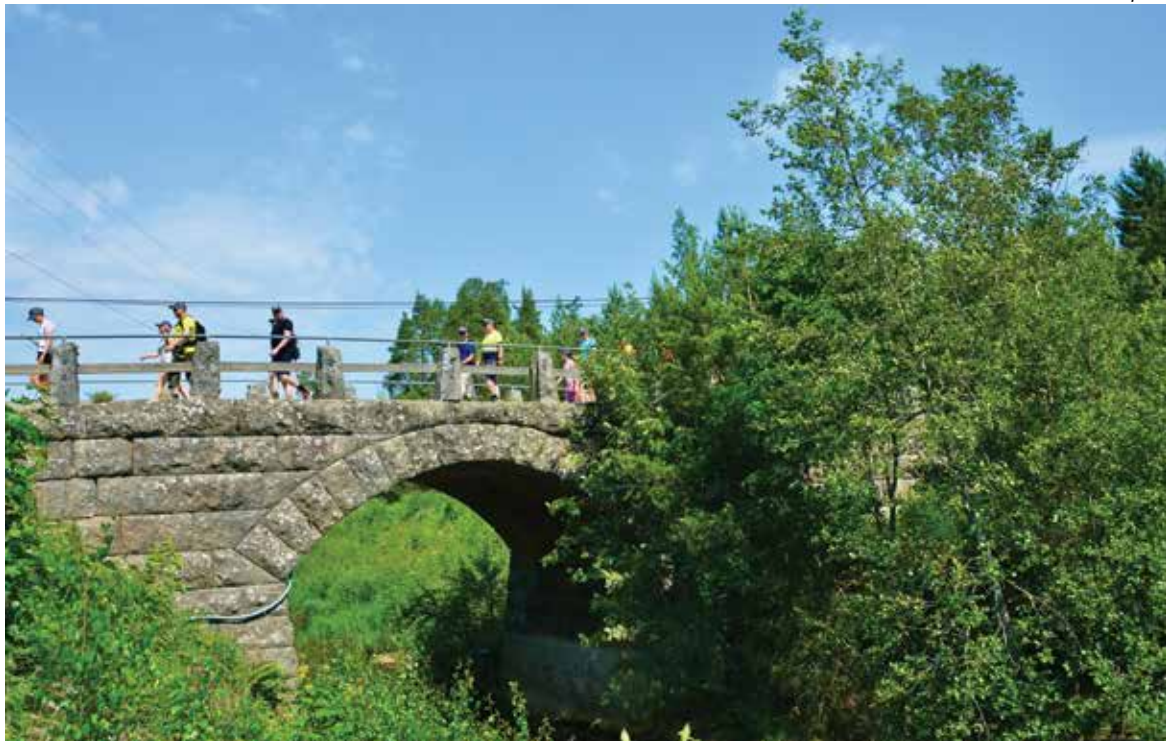
Sirppujoki ylitettiin Sorolantien vanhaa kivisiltaa pitkin.
