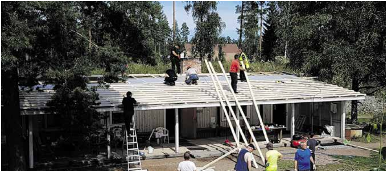
Roukkulin ampumarata remontoitiin perin pohjin.
